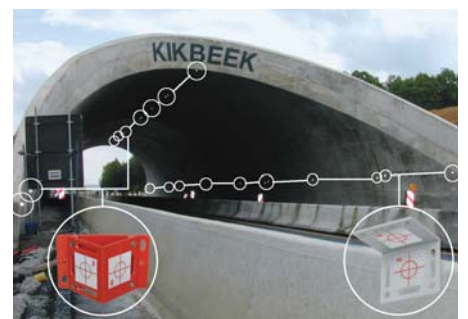
Nybygning Ecuduct Belgien
