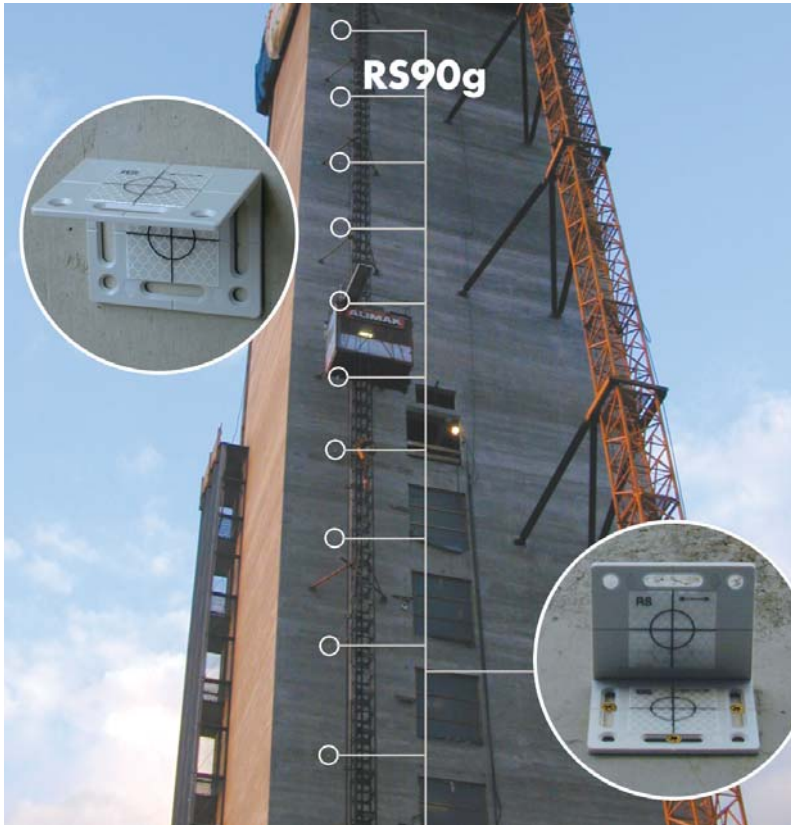
Glideforskalling med RS90g
