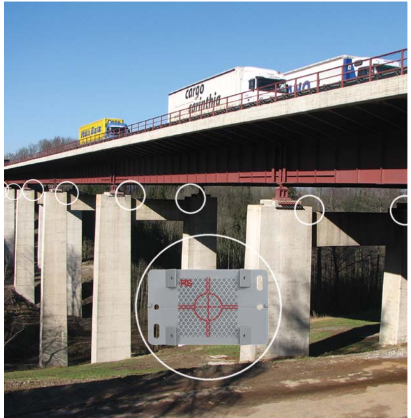
Beobachtung der Loitalbrücke mit RSAKZ6
