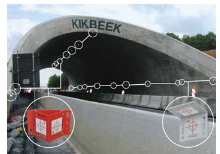
Puente en construcción en Bélgica
