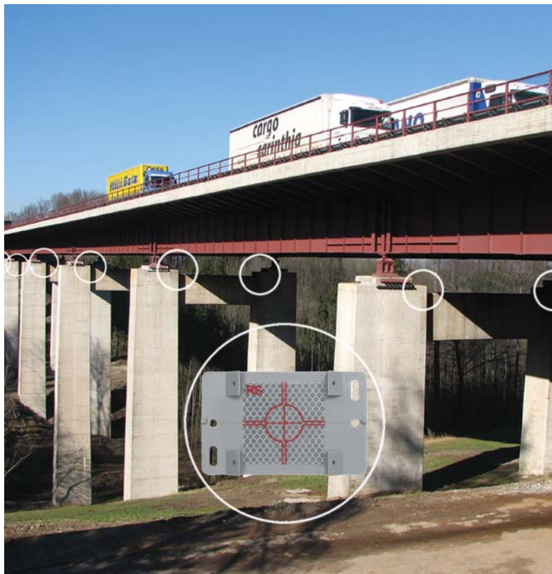
Observación del puente con RSAKZ6
