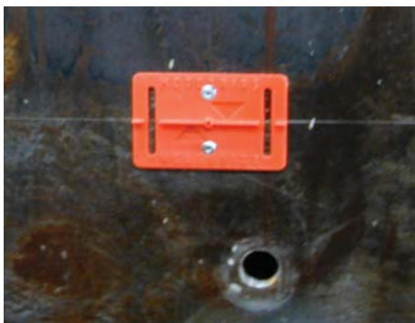
RS10r en el encofrado
