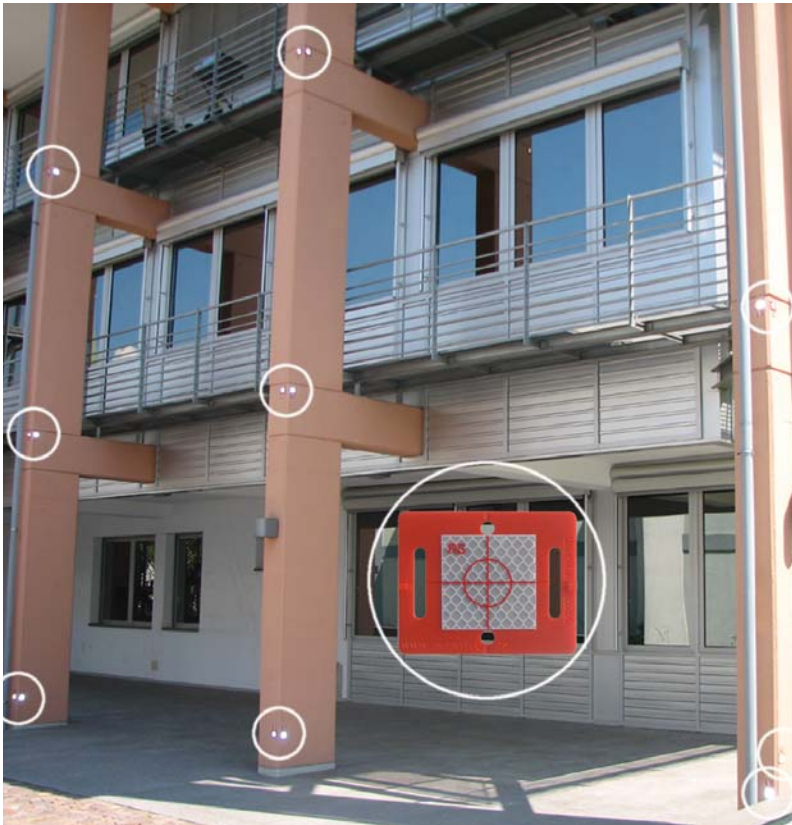
Observación de fachadas con RS60r
