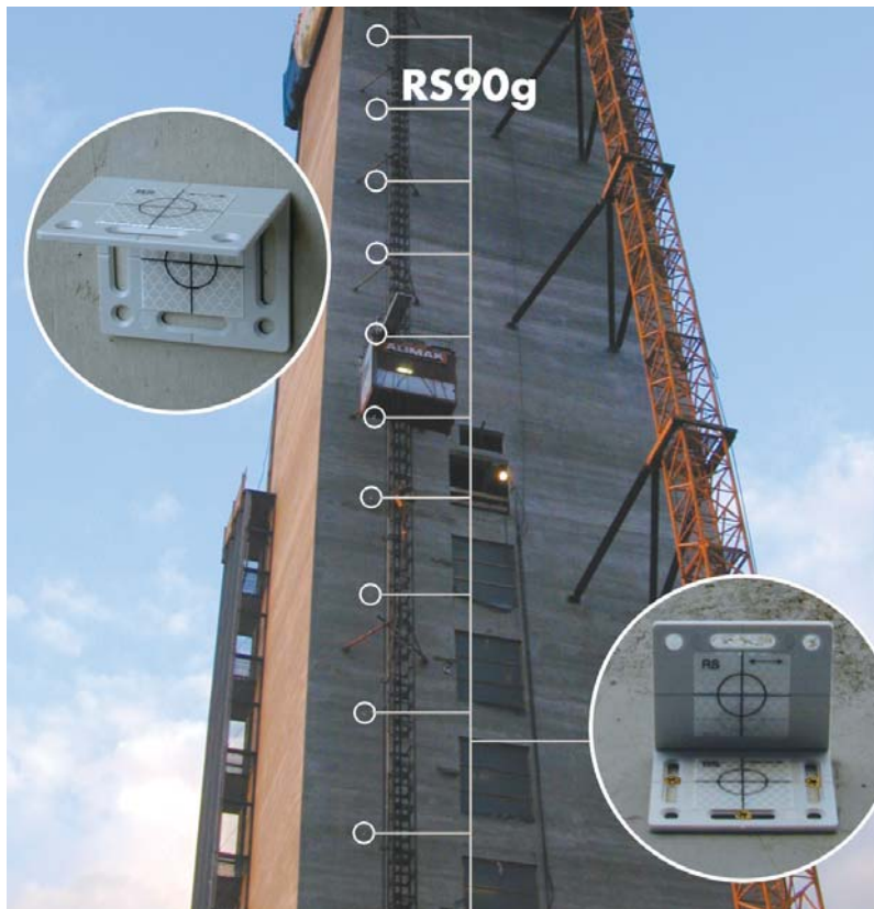
Encofrado deslizante con RS90g
