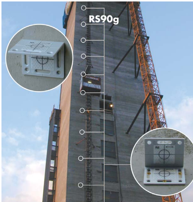
Coffrage grimpant avec RS90g
