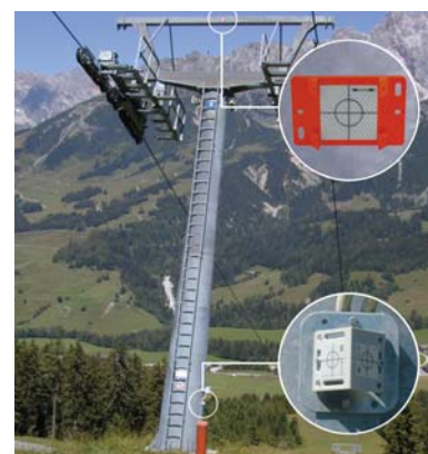
Observation de pylônes de téléski avec RSAKZ6r et RSAM80g
