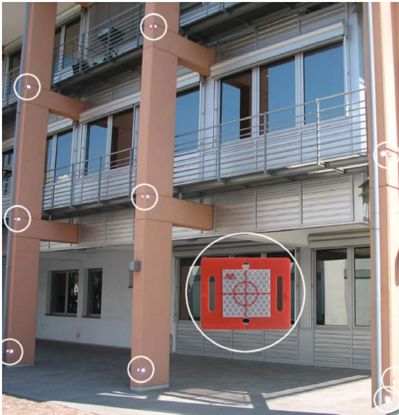
Osservazione di facciate con RS60r
