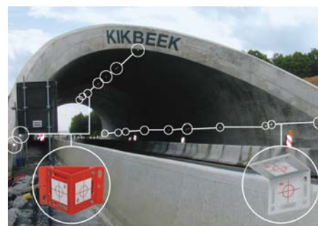
Nuova costruzione Ecluduct Belgio
