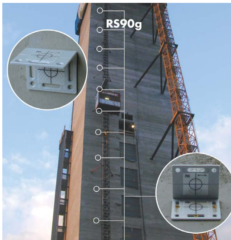
Cassaforma rampante con RS90g
