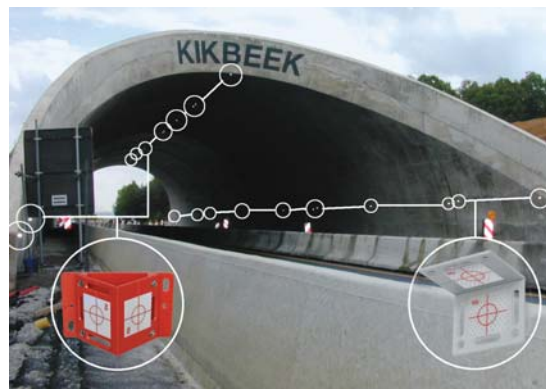
Nybygget akvedukt i Belgia
