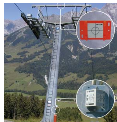
Observasjon av skiheisstolper med RSAKZ6r og RSAMBOg
