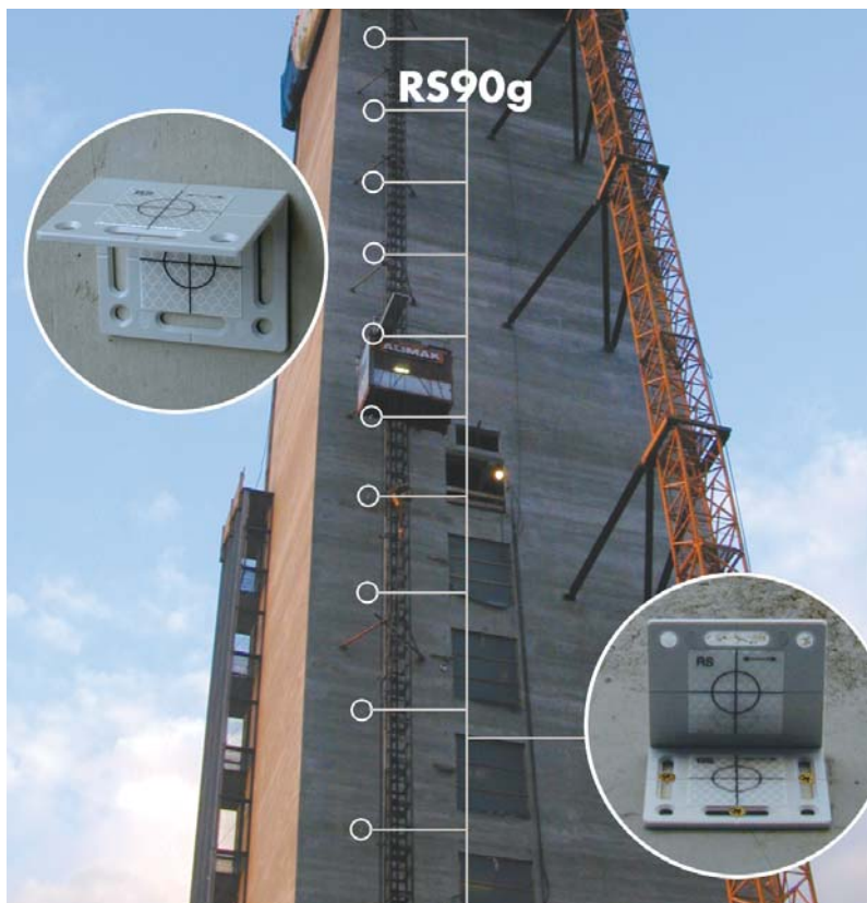
Glideforskaling med RS90g
