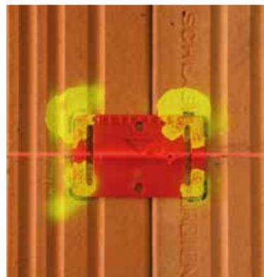
RS21r geklebt, fixiert und farbig überprüßt – Manipulationen werden somit ausgeschlossen.
