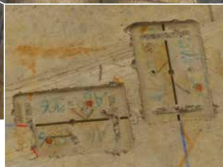
Die Negativabdrücke werden nach dem Entfernen der Deckenschalung sichtbar.
