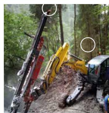
Einsatzbeispiele RS193rM als Fixpunkt auf unterschiedlichen Oberflächen und zum exakten Ausrichten der Bohrlafette.
