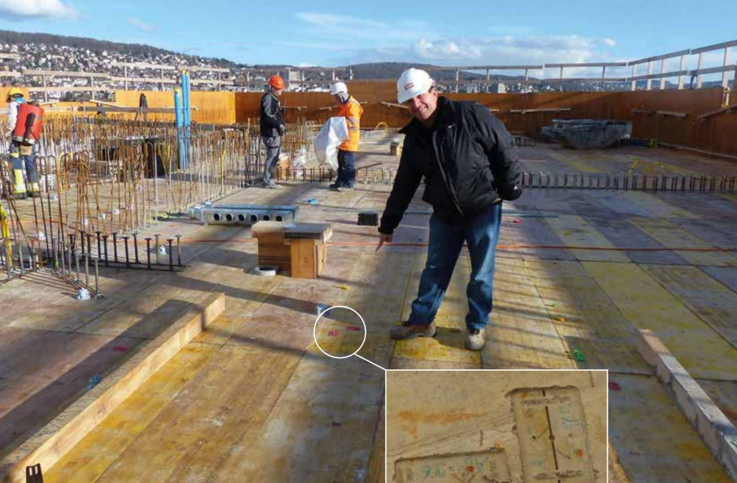
Ideal für Betonbaustellen ohne Putzarbeiten und zur dauerhaften Sicherung von Achsen als Negativabdruck im Beton.
