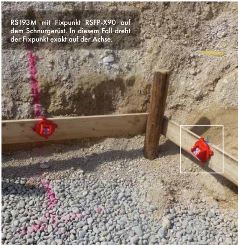
RS193M mit Fixpunkt RSFP-X90 auf dem Schnurgerüst. In diesem Fall dreht der Fixpunkt exakt auf der Achse.
