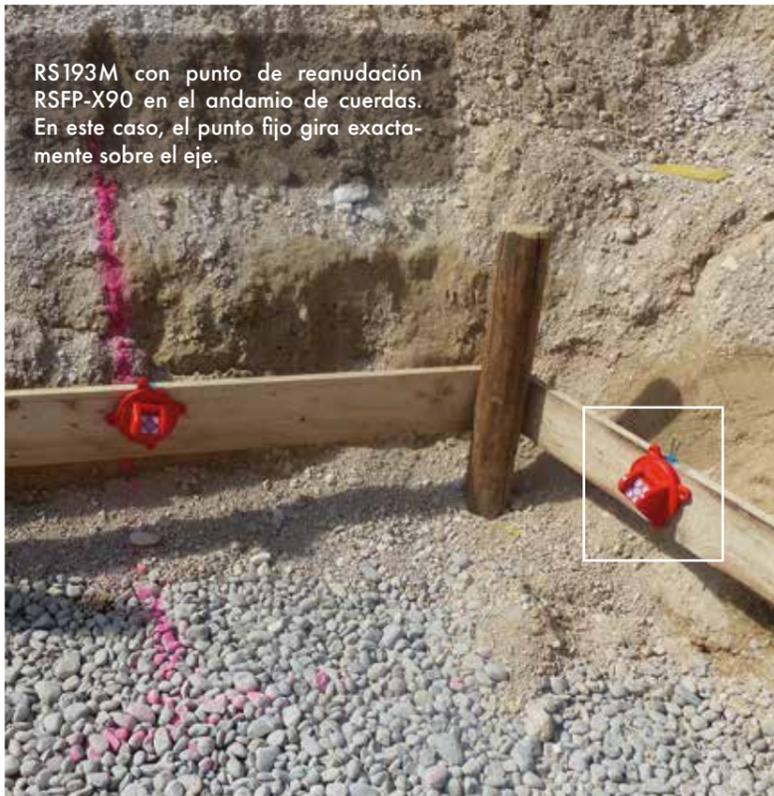
RS193M con punto de reanudación RSFP-X90 en el andamio de cuerdas. En este caso, el punto fijo gira exactamente sobre el eje.
