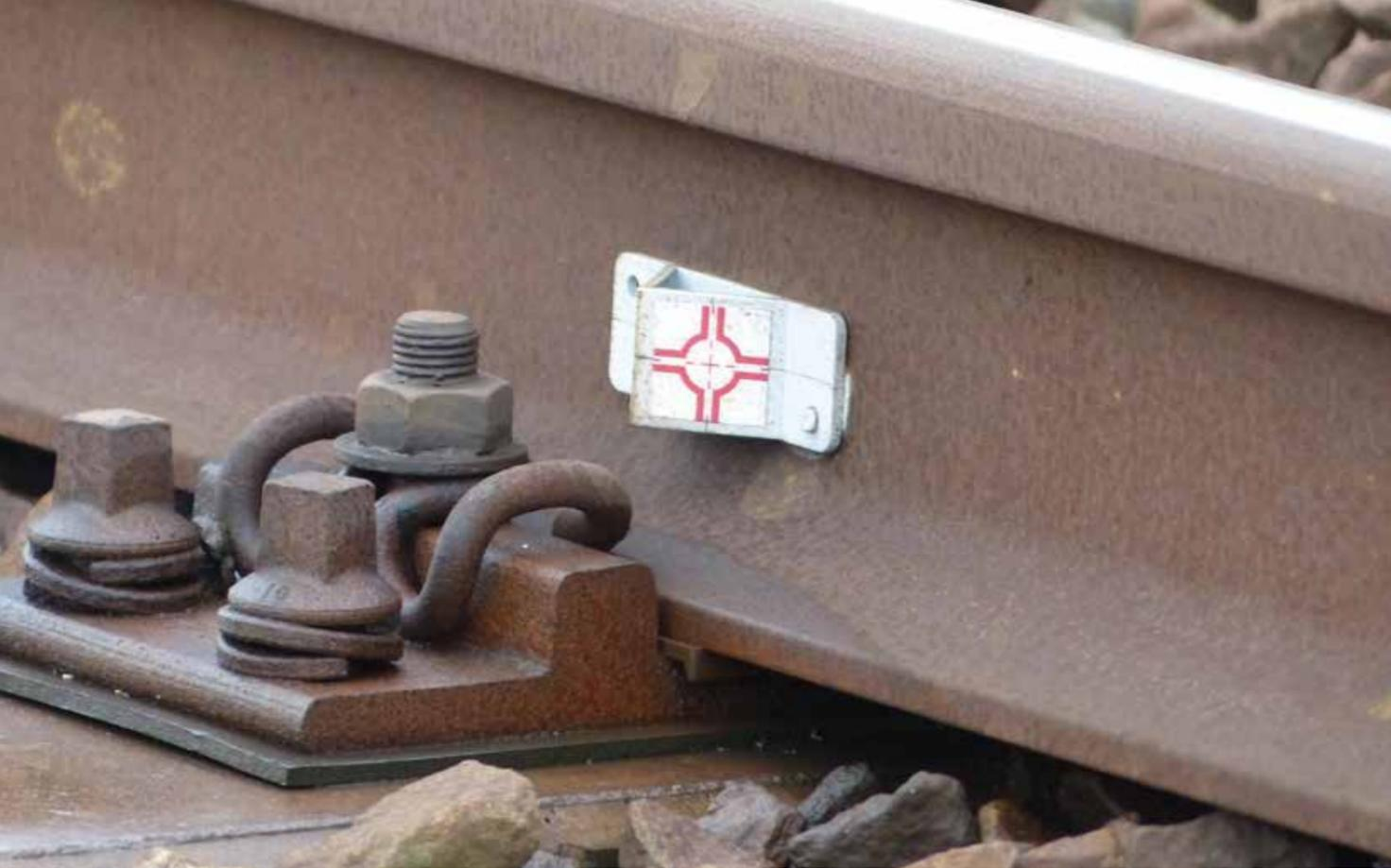
Seguimiento en la pista. Montaje rápido y sencillo con nuestro adhesivo de montaje RSMK-FIX.
