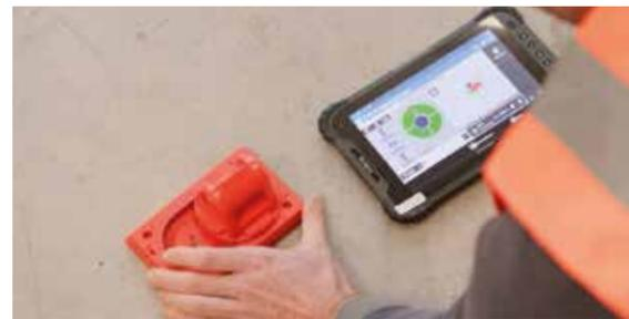
Mueva la ayuda para trazar en la placa base hasta alcanzar la posición objetivo, visible en el círculo verde
