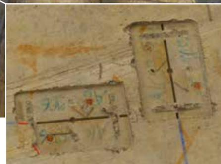
I calchi negativi diventano visibili una volta rimossa la cassaforma del solaio.
