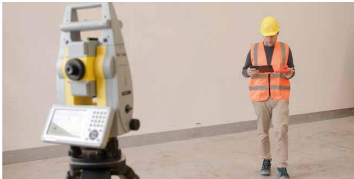
Tracciatura con RS150M e la stazione totale robotizzata
