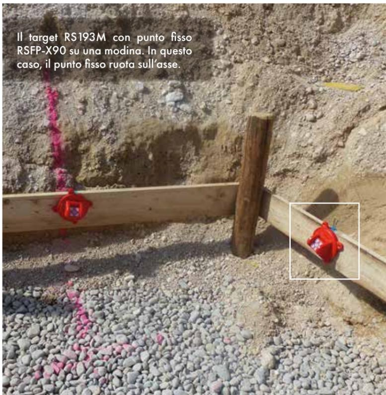
Il target RS193M con punto fisso RSFP-X90 su una modina. In questo caso, il punto fisso ruota sull'asse.
