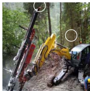
Esempi di applicazione del target RS193rM: come punto fisso su diverse superfici e come ausilio di allineamento per la perforatrice.
