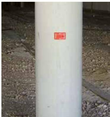
RS21r fijada sobre una columna redonda. El puente se recorta entre 4 y 5 veces con una cuchilla para moqueta.
