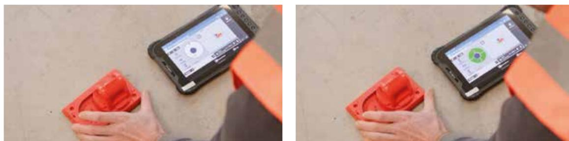
Mueva la ayuda para trazar en la placa base hasta alcanzar la posición objetivo, visible en el círculo verde
