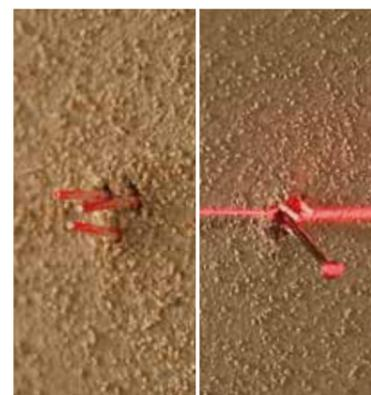
Les pointes élastiques garantissant un bon repérage du trait de niveau jusqu'à la fin des travaux de crépissage.
