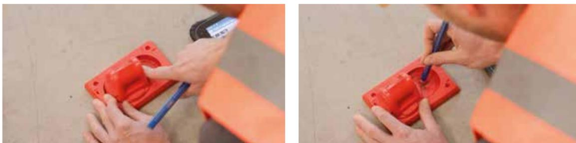
Décaler le prisme sur le côté et marquer la position cible avec un crayon
